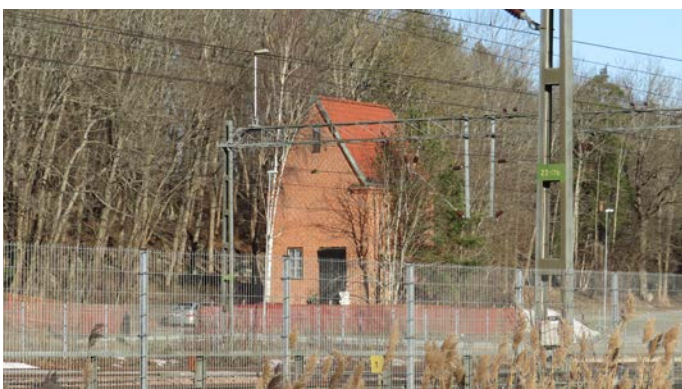
Ställverket invid järnvägen har inte givits skydd i detaljplanen och löper risk att försvinna.
